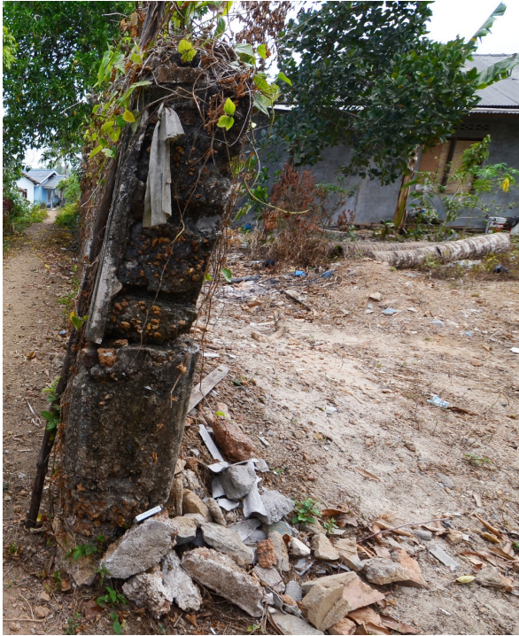
Puing-puing peninggalan Benteng Istana Kota Piring. Tembok yang tersisa memiliki tinggi antara 0,70 - 2 m, dengan tebal 40 cm.
