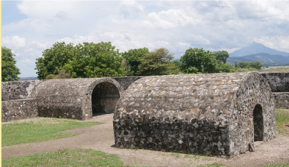
Bangunan dalam benteng Indrapatra, Aceh Besar. Benteng ini secara keseluruhan dibuat dari batu dengan spesi pasir dan kapur.
