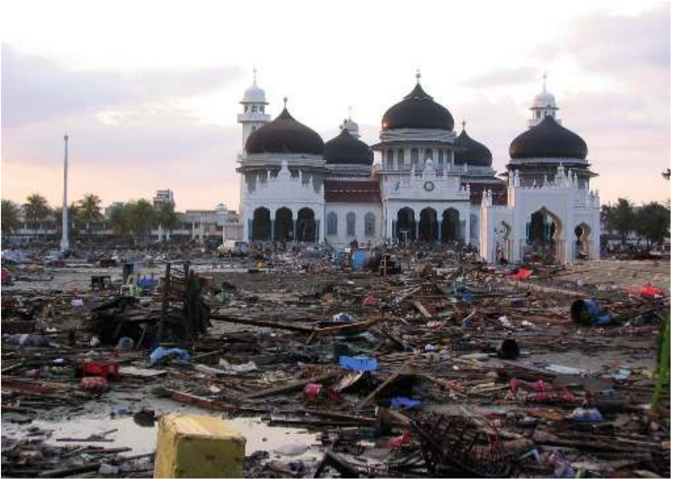
Kondisi di sekitar Masjid Baiturrohmah, Banda Aceh setelah terjangkit tsunami 26 Desember 2004 (Sumber: Biro Pers dan Media).
