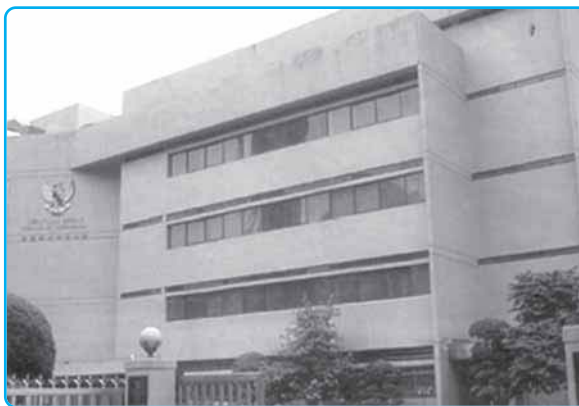
Gambar 4.4 Salah satu Gedung Kedutaan RI di negara lain.
