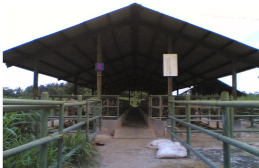
Gambar 4. Kandang sapi yang mempunyai atap tipe A dengan dinding berupa pipa – pipa besi
