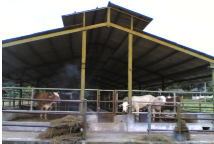
Gambar 3. Kandang sapi yang tipe atapnya berbentuk monitor dari bahan asbes.
